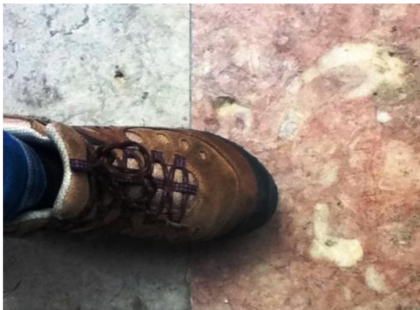
Fig.3- Calcário esbranquiçado e calcário rosado com fósseis de rudistas (chão da estação)
